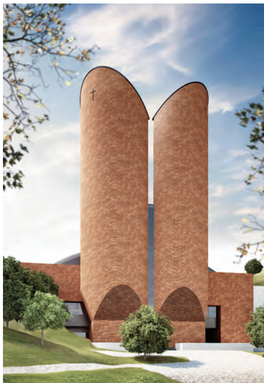
Cattedrale di Nostra Signora del Rosario Namyang Corea del Sud 2011, in fase di realizzazione.
