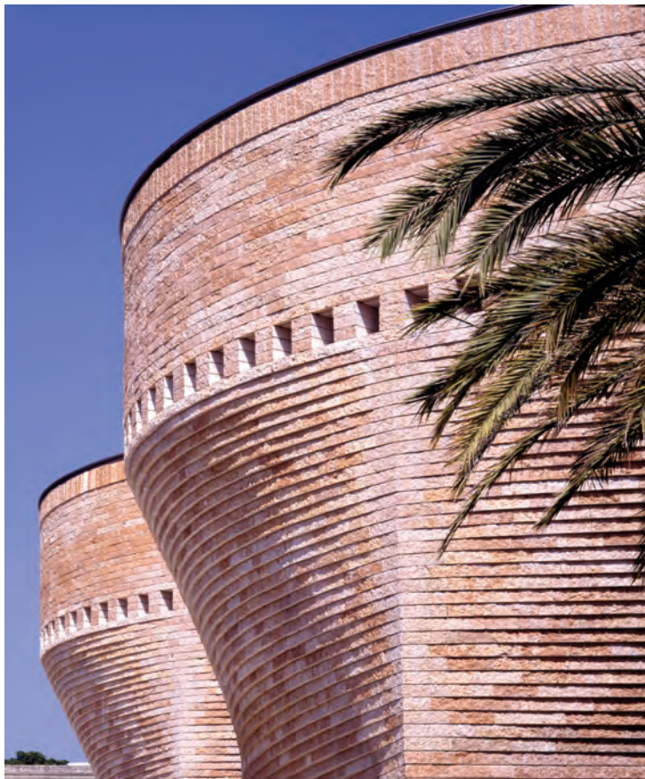
Sinagoga Cymbalista e centro dell'eredità ebraica Tel Aviv, Israele, (dettaglio delle due torri che ospitano al piano terra la sinagoga e la sala conferenze), 1996-98.
